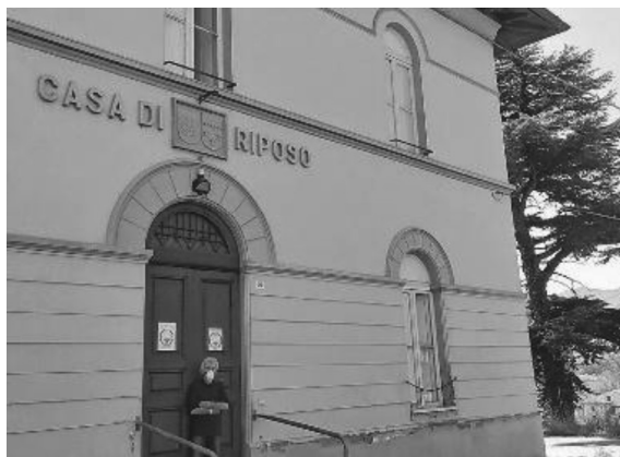
L'ex casa di riposo di Santa Sofia, fabbricato in via Porzia Nefetti
