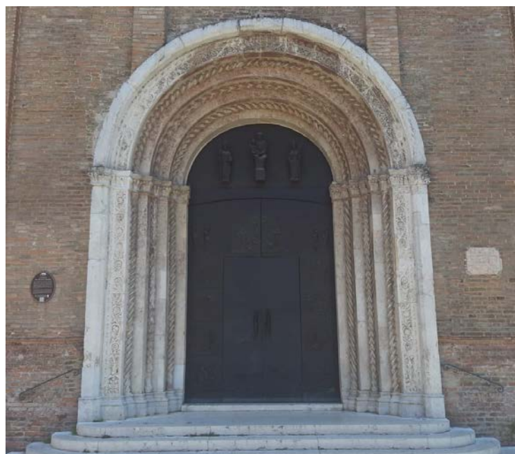
In alto, il campanile ingabbiato per realizzare i lavori. Sotto, il portale della cattedrale, che resterà chiuso fino alla fine di settembre per altri interventi
