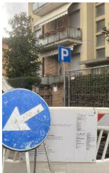
Un cantiere nella zona di San Rocco
