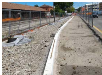
I lavori in corso
