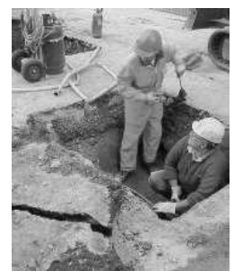
Operai al lavoro
