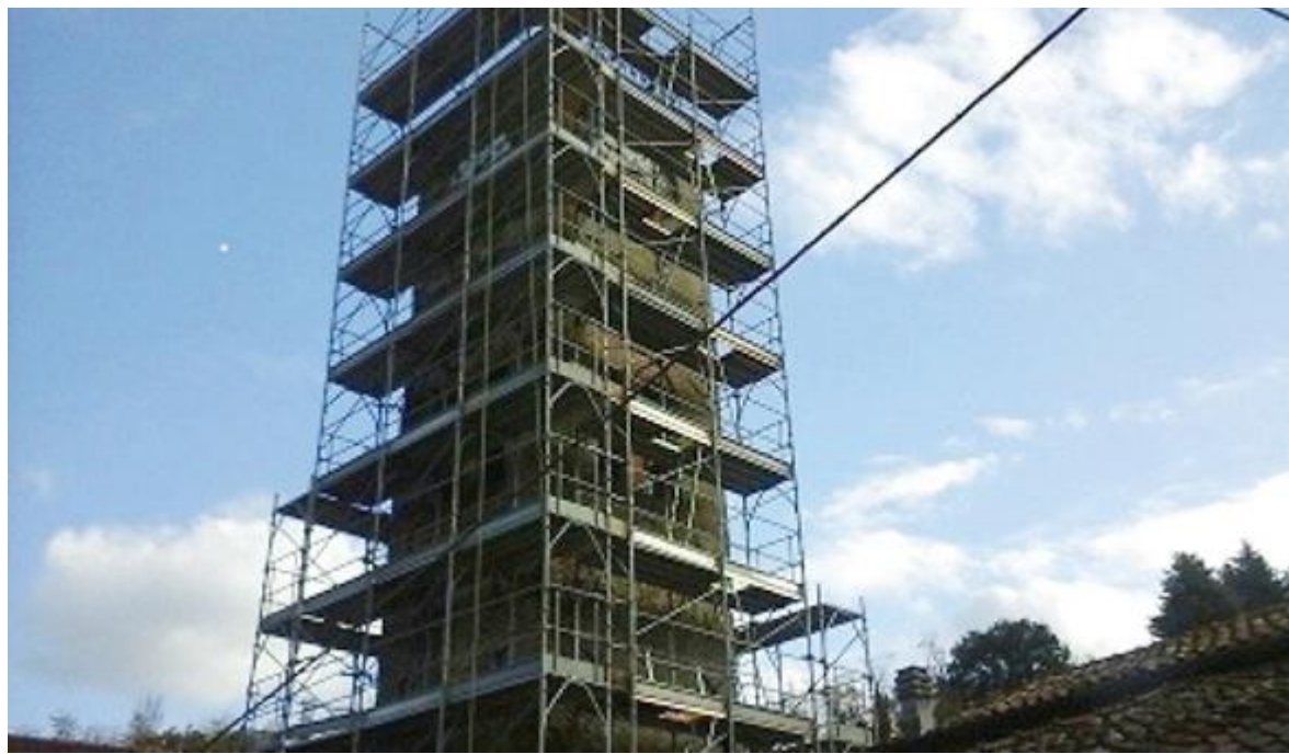
STORICA La torre-campanile 'ingabbiata' per i lavori come si presenta attualmente
