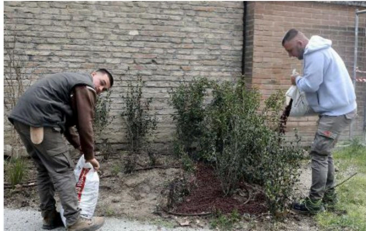
Una fase della realizzazione del 'Giardino Alzheimer' in un'area dei Giardini Pubblici di Cesena (foto Luca Ravaglia)
