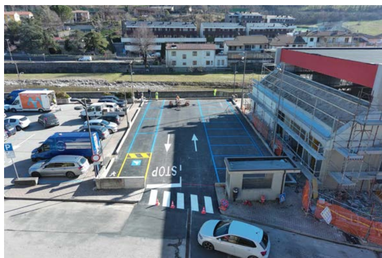
Il parcheggio Orto Fedelino recentemente ampliato a San Piero in Bagno
