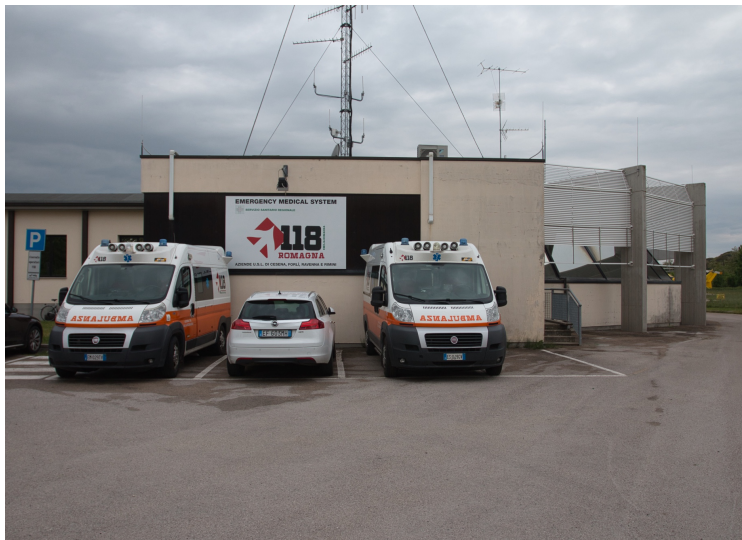
La centrale operativa del 118 a Ravenna
