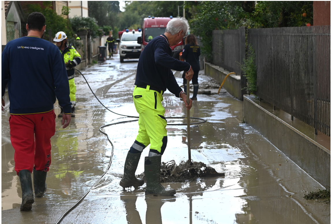
Un operatore al lavoro per sbloccare un tombino intasato dopo l'allagamento di una strada FOTO FABIO BLACO
