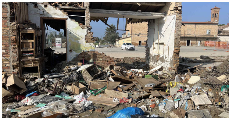
Una casa distrutta a Traversara dopo l'alluvione del 2024
