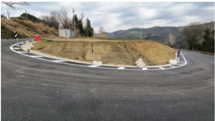
I lavori lungo la strada comunale di Montemaggiore
