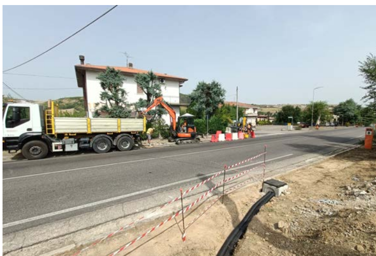
Il cantiere dei lavori lungo la Sp4
