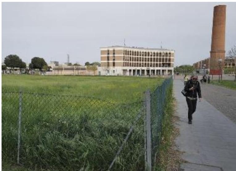
L'area dei Portici dove dovrebbe sorgere la struttura, in alto l'assessora Barbara Rossi
