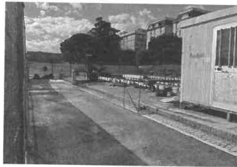
I lavori alla ciclostazione che sarà pronta nella prossima estate
