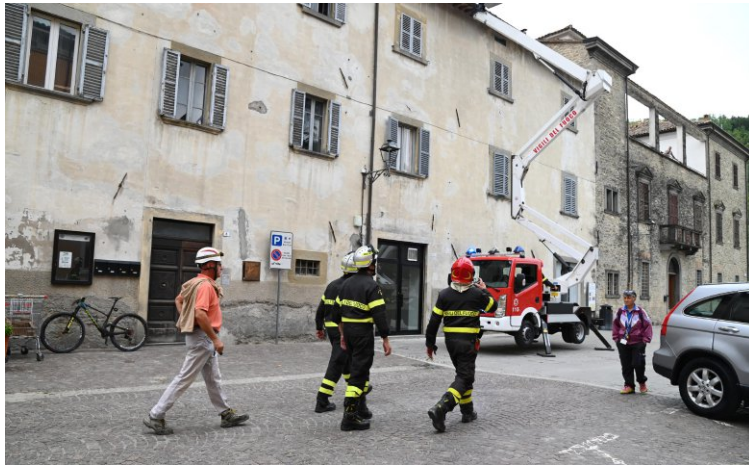
Controlli agli edifici dopo il terremoto a Tredozio FOTO FABIO BLACO
